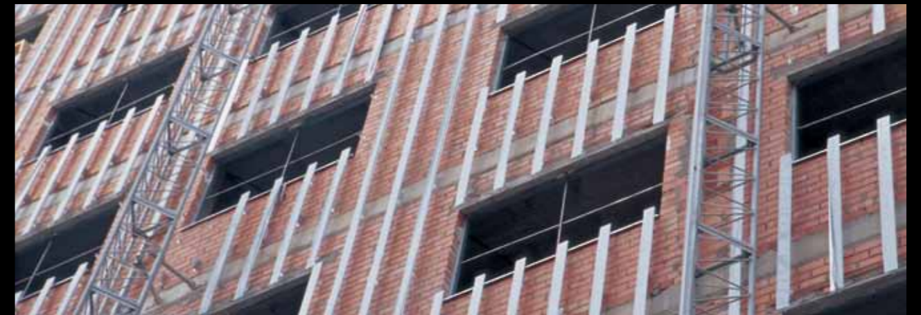
Instalación de la perfilería...
